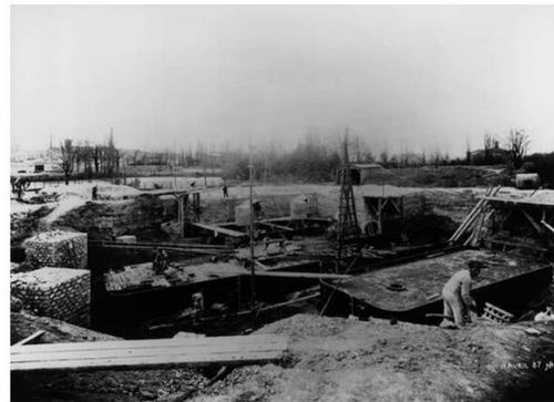
(25) Fondations caissons à air comprimé
